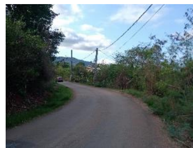
Voie d'accès existante
