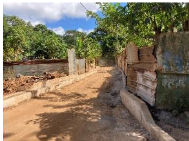
Piste en cours de viabilisation
