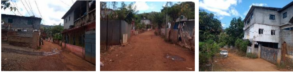
Pistes et bâtis existant sur le périmètre d'OAP
