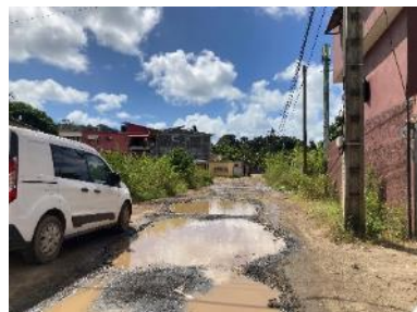
Accès transversal depuis le lycée des lumières
