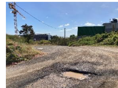
Accès à l'espace économique existant
