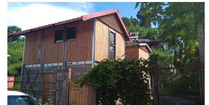
Projet d'auto-construction encadré d'habitation
