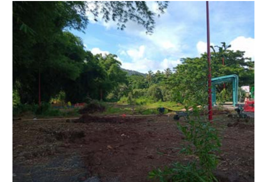
Travaux d'aménagement du Parc Ounafassi, Dembéni
