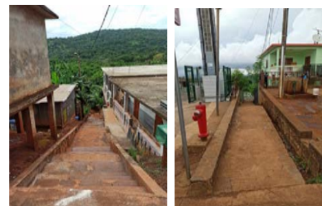
Escaliers à Hajangoua et Ongoujou
