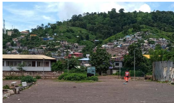
Construction dans la pente sur la commune de Kawéni avec une absence d'intégration paysagère des constructions
