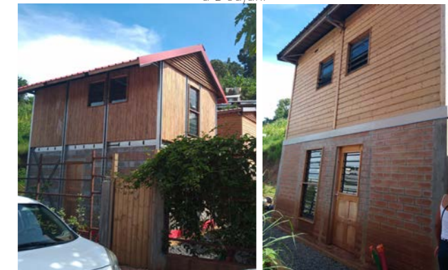
Opération pilote de deux maisons en auto-construction encadrée à Doujani
